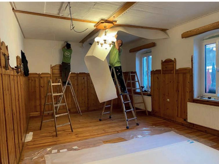
**Textil-Spann-Systeme** können an Decken, Wänden oder als frei stehende Elemente installiert werden und tragen zur akustischen Optimierung verschiedener Räume bei. Neben der Erschaffung einer angenehmen Klangumgebung ist es möglich, die Textilien mit verschiedenen Farben, Mustern und Formen zu gestalten.
